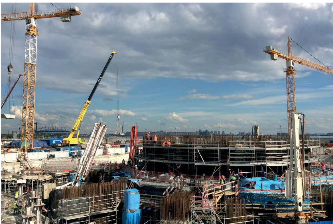
«Лахта центр» – ход строительства
